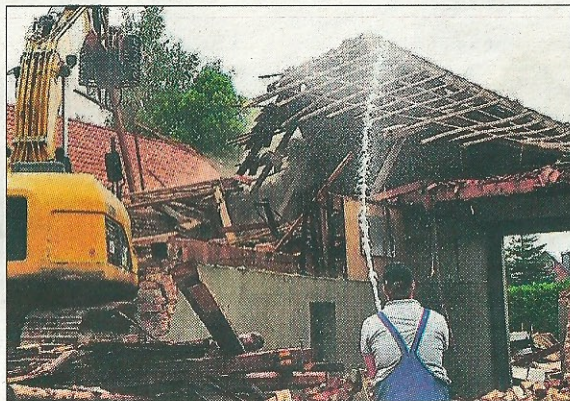
Das Gasthaus Haberlah wird abgerissen und weicht einem Neubau. Wiborg
